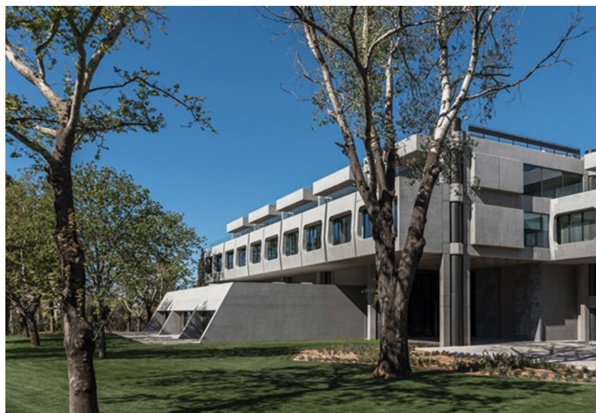
Επαγγελματικό Κτίριο Αττική
