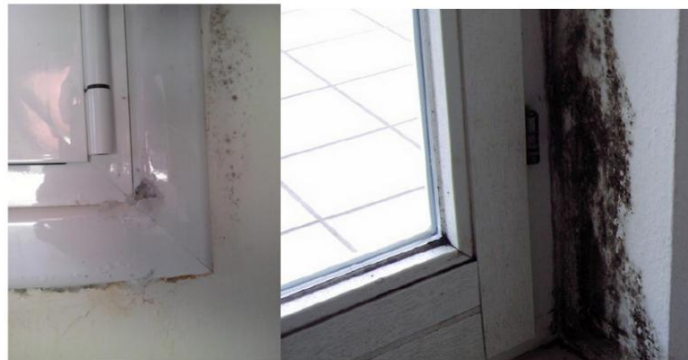
Εικόνα 4.1: Παραδείγματα δημιουργίας μούχλας λόγω κακής στεγάνωσης.
